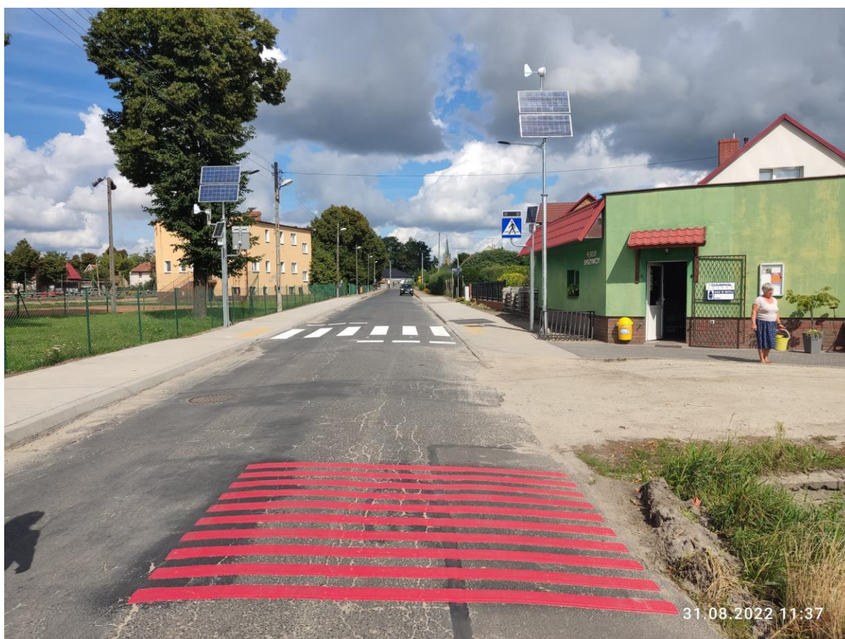
Ulica Sportowa – stan po realizacji
